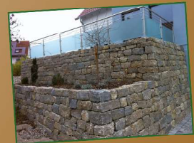
Gabionen und Mauern
