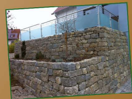
Gabionen und Mauern
