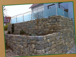
Gabionen und Mauern
